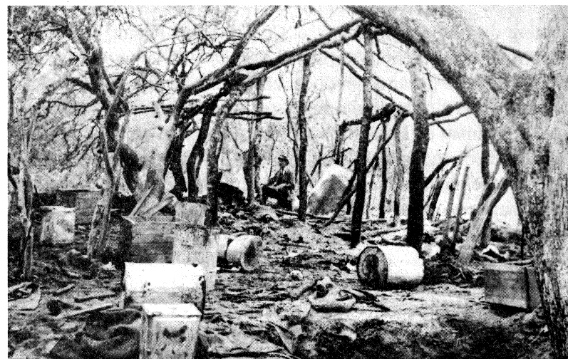
Después del incendio
